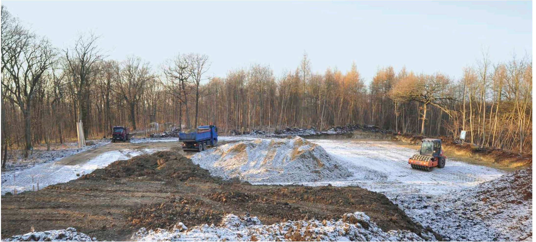
DEN BODEN BEREITEN: AN DIESER STELLE SOLL EIN 35 TONNEN SCHWERER BOHRTURM STEHEN
